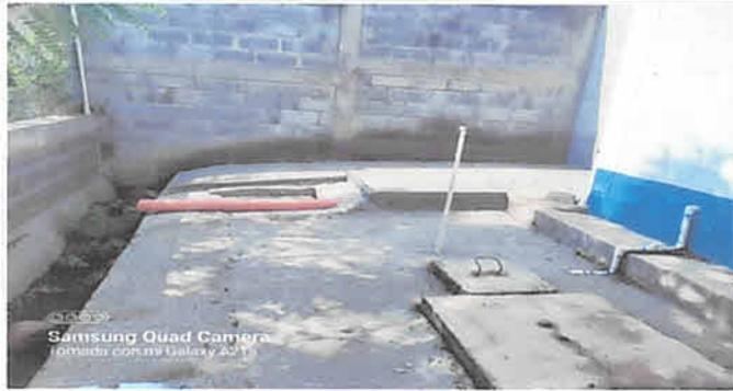
Foto 1: Instalación de tubería en patio para caídas de aguas pluviales Terminado.
